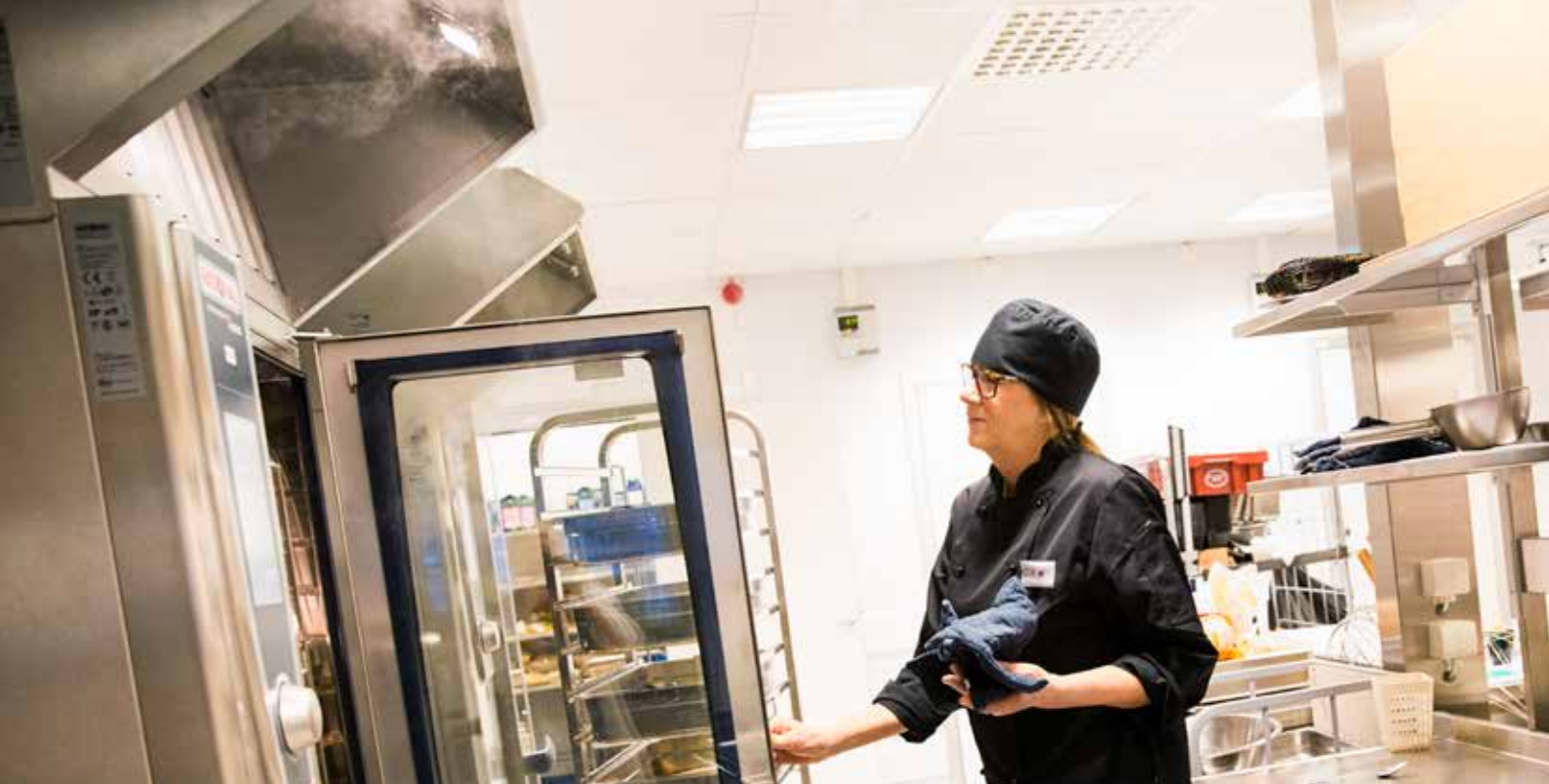
Ozonet möter den feta frånluften direkt vid spiskåpan och renar omedelbart.
