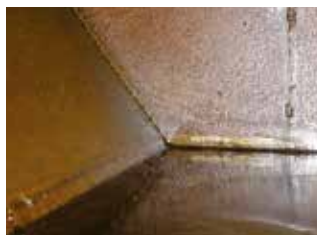
Imkanal före installation av ozon
