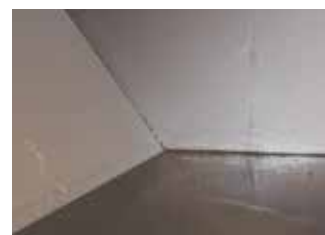
Imkanal efter installation av ozon
